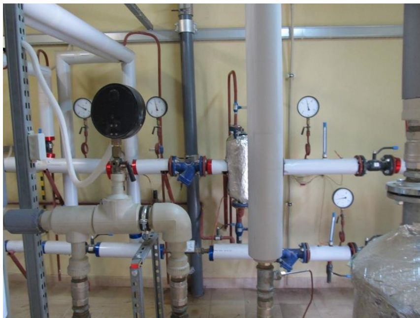
Fotografia nr 31 Budynek PPUK – Węzeł cieplny
