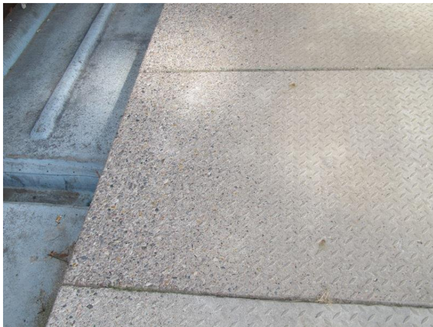
Fotografia nr 20 Zniszczona powierzchnia peronu roboczego
